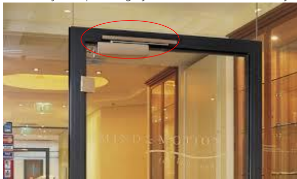
Samozapiralni mehanizem na vratih – zagotavlja, da so vrata, ko jih ne uporabljamo, ves čas zaprta
