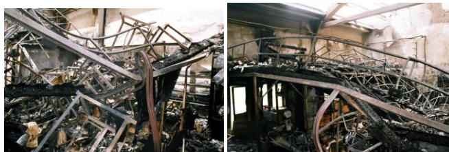
Obnašanje nezaščitene jeklene konstrukcije v požaru
