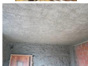
Slika armiranobetonskega stropa Tečaj za višjega gasilca-GZ Kamnik
