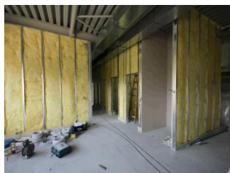
Stene iz mavčno kartonskih plošč
