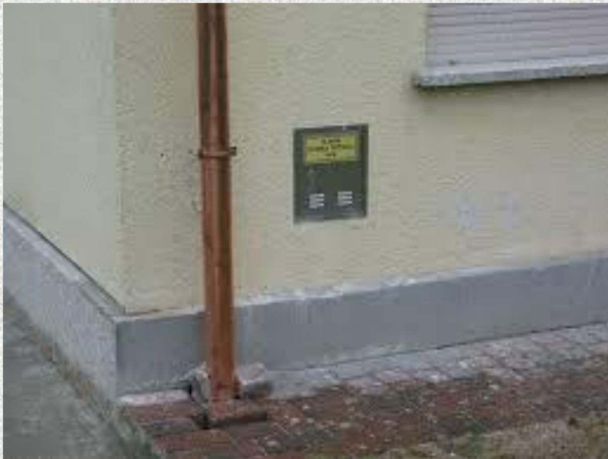
Praktični prikaz glavne plinske požarne pipe
